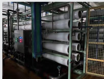
煤制乙二醇废水资源化项目
